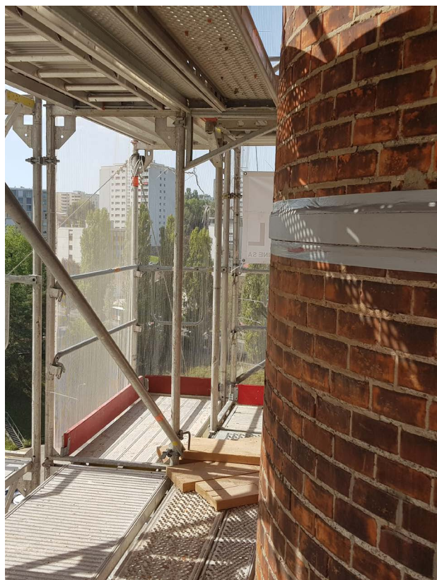
Der ursprüngliche Cardinal Schornstein in Renovation.
