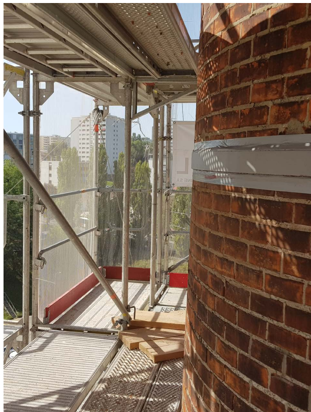
La cheminée de l'ancienne brasserie Cardinal en rénovation.
